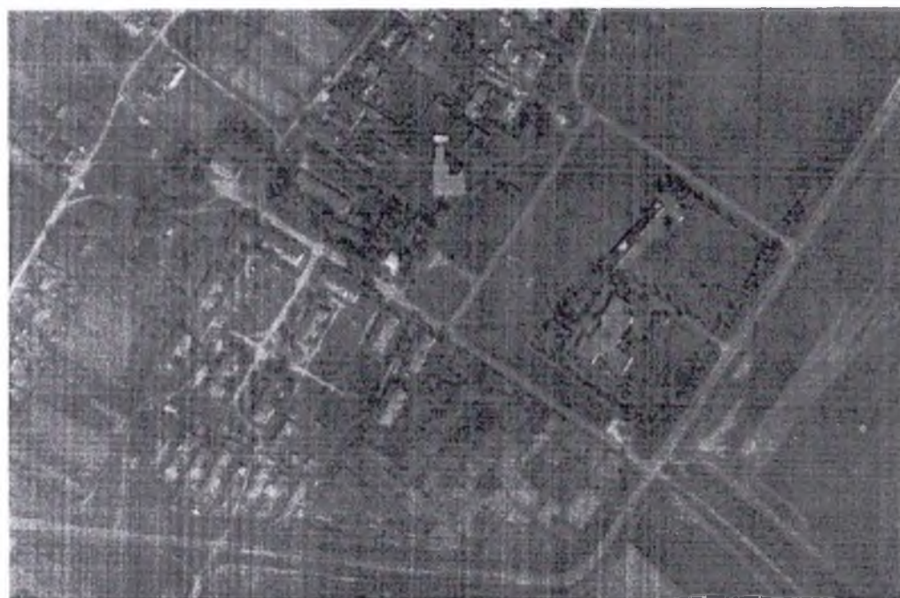
Рис. 6 Отапливаемая зона котельной с. Чичково, ул. им. Л.Мирошина, 16.
